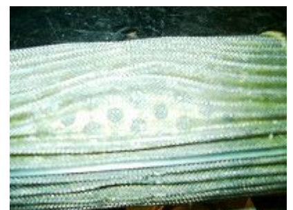
溝が変形している
